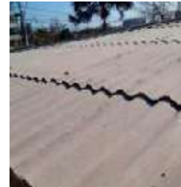
Techumbre de asbesto cemento
